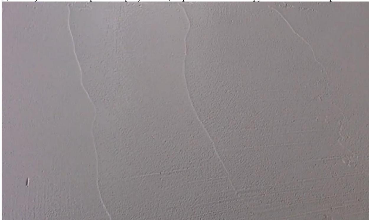
Для получения «живого», более фактурного рисунка, нанесите шпателем грубый рисунок первым слоем. Фактура определит живость результата. Наносите второй слой СТЮКа после того, как высохнет первый. Этим слоем вы заполняете фактурные изменения, таким образом выравнивая поверхность. Благодаря разнице во впитываемости создаются цветовые нюансы.
